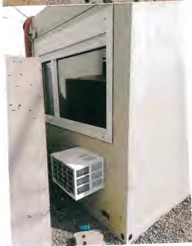
Buňky BTAS po osazení klimatizačních jednotek
